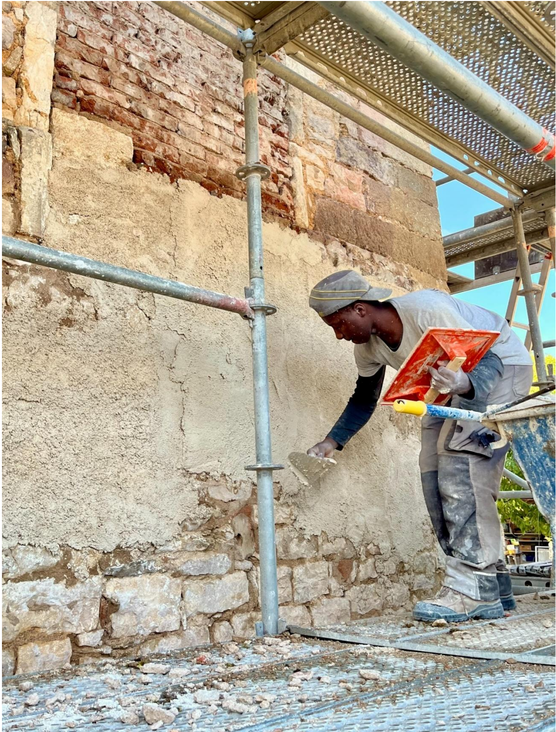
Restauration des enduits extérieurs de la chapelle de La Cordelle. Ici, sur la face nord, les ouvriers ont découvert une ancienne porte (comblée en briques), qui devait donner accès au couvent franciscain du XVIIe siècle, aujourd'hui disparu.
